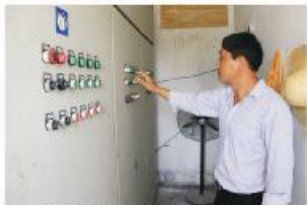
▲工作人员正检查造浪机组工作情况
