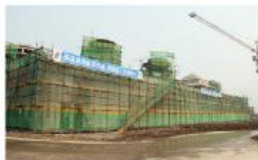
▲建筑项目施工现场
