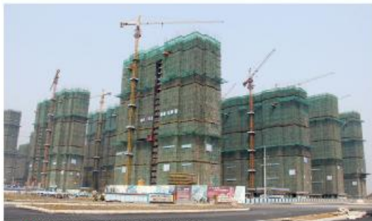
▲建设集团十分重视施工现场扬尘治理工作
