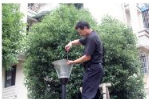
▲物业人员正在维修损坏的路灯
