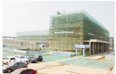
▲综合客运枢纽南站主站房工程外景
