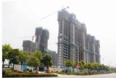
▲现沁园小区东区高层11#-17#楼工程外景
