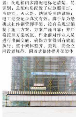
▲规范的架体和安全隐患牌
