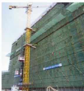
▲铜冠花园2号楼工程施工现场
