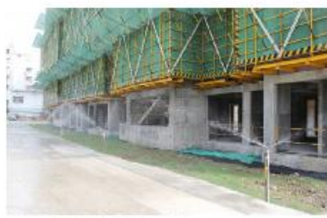
▲自动旋转式喷水龙头在降尘
