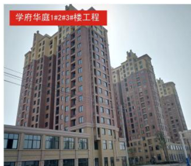
工程名称：学府华庭1#2#3#楼工程 所获奖项：市级安全标准化示范工地（小区）、市级建设工程质量标准化示范工程 表彰单位：芜湖市住房和城乡建设委员会
