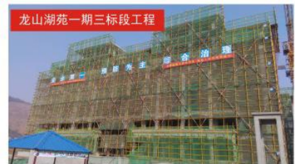
工程名称：龙山湖苑一期三标段工程 所获奖项：市级建筑施工安全质量标准化示范工地 表彰单位：铜陵市建筑工程管理局
