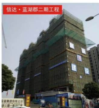
工程名称：信达·蓝湖郡二期工程 所获奖项：市级安全标准化示范工地（小区） 表彰单位：芜湖市住房和城乡建设委员会
