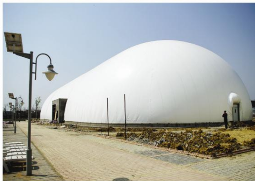
▲ 正在建设中的中视新影大浦3D影院项目
